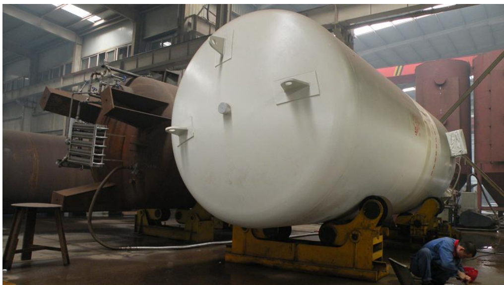
图 1：核电站压力容器焊接
